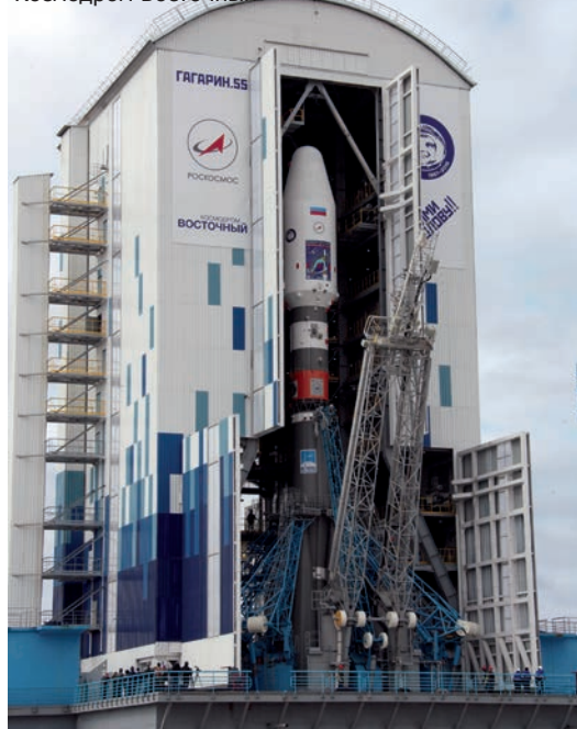
Мобильная башня обслуживания РКН «Союз». Космодром Восточный
