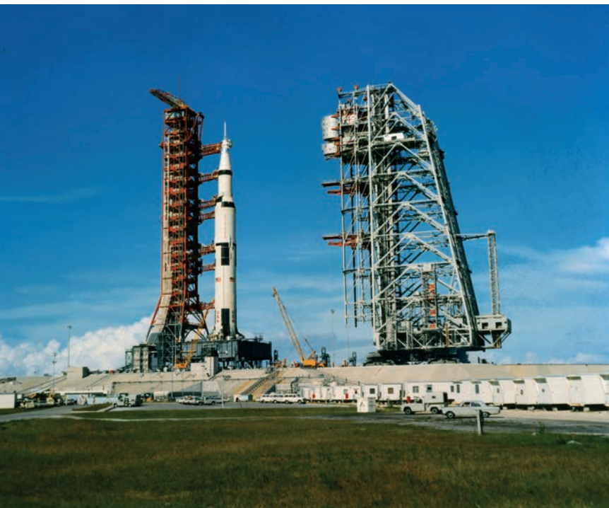
«Сатурн-5» перед запуском «Аполлон-11» установлен на мобильной пусковой платформе, слева – стартовая заправочная башня, справа – МБО
